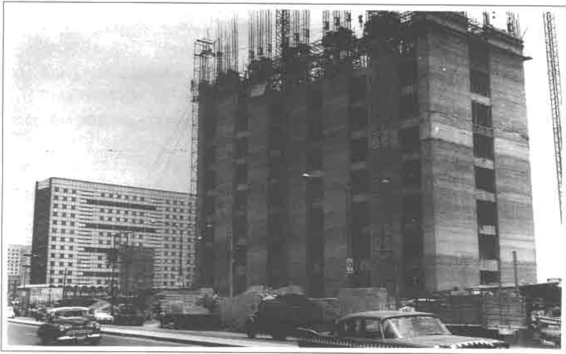
Construcción de la torre de la SRE en Tlatelolco (1963).
