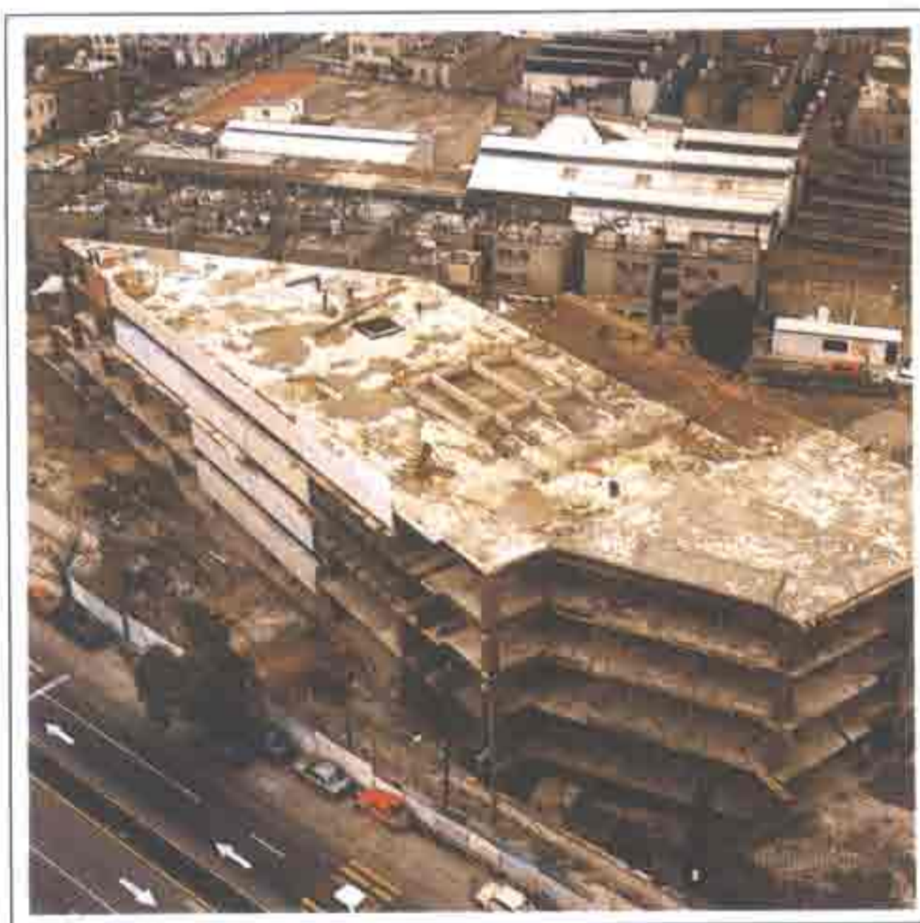
Etapa de construcción del edificio anexo a la torre de la SRE. (1993).
